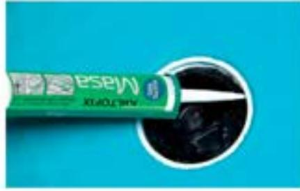
**11** Do uszczelnienia pierścienia odpływu najlepiej użyć uszczelniającego Kiltto Masa. Kompatybilność Kiltto Kaivolaippa z większością typów odpływów podłogowych została sprawdzona i potwierdzona.
