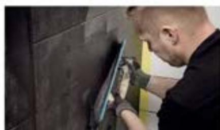
**13** Fugowanie należy rozpocząć od ścian. Fuge **Kiltto Saumalaasti** nanosić gumową pacą i wyciągać w spoiny. Zaczekać 15-30 minut i zmyć nadmiar fugi mokrą gąbką.
