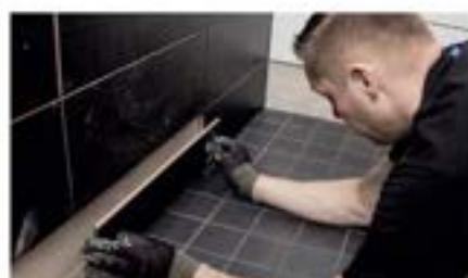
**12** Po wyschnięciu kleju, można przykleić najniższą warstwę płyt na ścianie i rozpocząć fugowanie.
