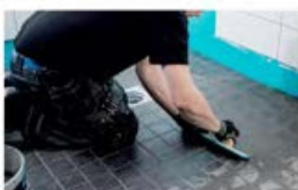
**13** Nakłóż Kiltto Lattiasumalaasti lub Kiltto Saumalaasti za pomocą kielni gumowej i wciśnij w fugi. Zaczekaj 15-30 minut i zmyj gąbką nadmiar wody. Używaj ćwierć gąbki, gdyż nadmiar wody może odbarwić kolor fugi. Fugi na ścianach mogą być wyprofilowane kawałkiem grubego kabla elektrycznego.
