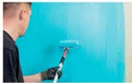
**2** Wymieszaj hydroizolację KILTO Kerafiber zawsze przed użyciem. Wzmocnij narożniki, łącza, połączenia różnych materiałów podłożu za pomocą taśmy KILTO Nurkkavahvikenauha. Nakłóż taśmę na mokrą hydroizolację Kerafiber i nałożyć drugą warstwę hydroizolacji Kerafiber na taśmę, aby zapewnić dokładne zwilżenie.
