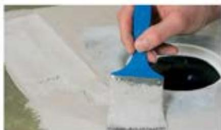
**7** Nakłóż taśmę **Kiltto Nurkkavaahvikenauha** na brzegi **Kiltto Kaivolaippa** bez wzmacniania i nakłóż pędzlem Keramix aż do pierścienia.
