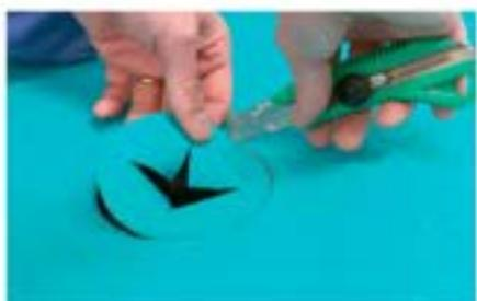
**6** Po wyschnięciu wytnij okrągły otwór na odpływ podłogowy o średnicy o 40 mm mniejszej niż średnica odpływu (postępuj zgodnie z instrukcją producenta odpływu podłogowego). Grubość Kerafiberu wokół odpływu powinna wynosić minimum 1,2 mm.
