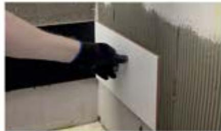
8 Płytki rozpoczęnamy układając od drugiego rządu używając klejów cementowych np. **Kilto Superfix DF**, **Flexfix** lub **Kilto Kerapid DF**.
