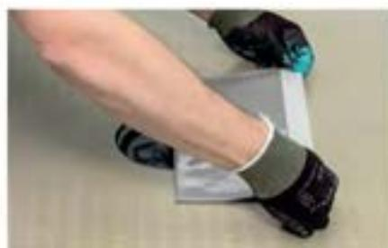
**8** Alternatywnie odpływ podłogowy może być uszczelniony samoprzyklepną uszczelką Kiltto Kaivolaippa. Nakłóż Kiltto Kaivolaippa na suchą, zagruzowaną powierzchnię i docisnij. Wytnij otwór na odpływ, zgodnie z zaleceniem producenta odpływu i włóż pierścień.
