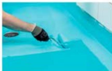
**5** Nakłóż walkiem drugą warstwę Kerafiberu i pozwól przeschnąć 6-12 godz. przed układaniem płytek/zmiana koloru. Sprawdź grubość powłoki Kerafiber. Nakłóż Kerafiber na cienkie lub puro-wate miejsca i pozwól powoli przeschnąć. Całkowite zużycie Kerafber powinno wynosić minimum 0,8 l/m<sup>2</sup> i grubość powłoki 0,5 mm na podłodze.
