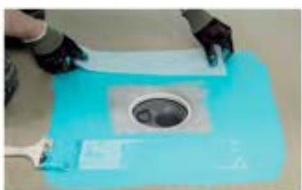
**9** Kiltto Kaivolaippa ma wzmacnienia po dwóch stronach, nanieś Kiltto Kerafiber na nie. Poza te dwie strony muszą być wzmacnione taśmą do tego przeznaczoną. Sprawdź, czy taśma zachodzi na Kaivolaippa minimum 30 mm.
