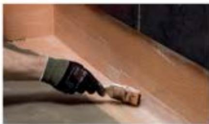
**1.** Zagruntuj podłoge **gruntem Kilto Keraprimer** zgodnie z oddzielną instrukcją. Rozpocznij wykonywanie hydroizolacji podłogi przez zaistalowanie **taśmy Nurkkavalvike** w narożniku i miejsca stykania się płyt. Upewnij się, że taśma jest dobrze przyklejona. Alternatywnie do narożników można użyć formatek wklęszych i wypukłych.
