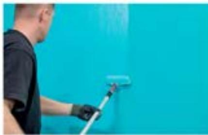
**2b** Użyj prefabrykowanych uszczelek do wlotów nur KILTO lub przycinaj taśmę KILTO Nurkkavahvikenauha do odpowiedniego rozmiaru. Wzmocnienia nałożyć w mokry Kerafiber i nałożyć drugą warstwę Kerafiberu na wzmacnienie w celu zapewnienia szczelności.
