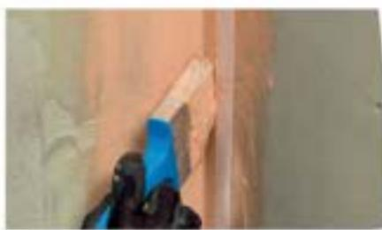
1. Zagruntuje podłożę gruntem **Kilto Keraprimer** zgodnie z [oddzielną instrukcją](#). Rozpocznij wykonanie hydroizolacji ścian przez zainstalowanie taśmy Nurkkavahvike w narożnikach i miejscu stykania się płyt. Upewnij się, że taśma jest dobrze przyklejona.
