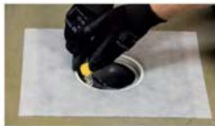
**3.** Wytnij otwór na odpływ podłogowy około 60 mm mniejszy niż średnica odpływu i zaistaluj pierścień zaciiskowy.
