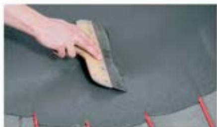
3 Do spadków i zainstalowania kabli można użyć również **Kestonit TERMO** lub **MultiPlan DF**. Należy przeczytać oddzielną instrukcję na temat wygładzania i gruntowania.
