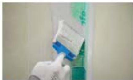
4 Przygotuj Keramix 1:1 (proporcje wagowe). Zainstaluj taśmę **Kerasafe Samanauha** lub taśmę **Kilto Nurkkavahvikenauha** w narożnikach, łącznicach i połączeniach różnych materiałów. Alternatywnie można użyć taśmy Kilto Butylinauha. Wciśnij taśmę w mokrą membranę Keramix i nanieś Keramix na taśmę, aby dobrze nasiąkła.
