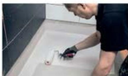
**10** Nakłóż wałkiem drugą warstwę Keramiku, pozwól wyschnąć min. 1,5 godz. (zmiana koloru) przed układaniem płytek. Całkowite zużycie Keramiku minimum 1,5 kg/m<sup>2</sup>, i grubość membrany 0,8 mm.
