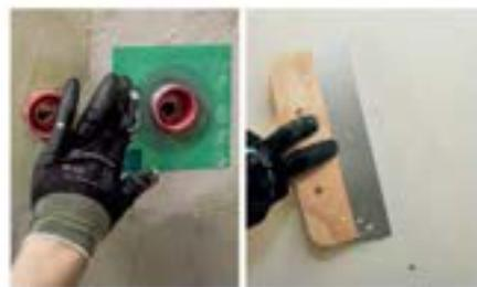
5 Główki wkrętów na płytach mozaiki można pokryć taśmą lub zakleić gotowym Kilto LW, jeśli to konieczne. Wpuszty nur można zabezpieczyć gotowymi okrągłymi formatkami uszczelniającymi, kawałkiem taśmy **Nurkkavahvikenauha** lub Keramixem o konsystencji pasty.
