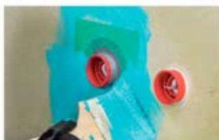
**1** Zagrunuj suche i odkurzone ściany gruntkiem KILTO Keraprimer (rozcieńczyć wodą 1: 1). Pozostawić do wyschnięcia na minimum 1 godzinę przed rozpoczęciem nakładania hydroizolacji. Uwaga: w razie potrzeby wygładzić podłoż odpowiednią do pomieszczeń mokrych gładzią KILTO.
