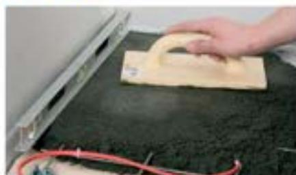
1 Kestonit MAXI służy do wylania podłogi. Należy użyć siatki stalowej. Do siatki można przytwierdzić kabły ogrzewania podłogowego.
