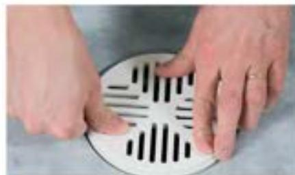
**6** Samoprzyklepna tkanina uszczelniająca **Kiltto Kaivolaippa** służy do uszczelnienia odpływu podłogowego. Przyklej ją na suchą, zagruntowaną powierzchnię i wcisnij mocno. Wytnij otwór (około 60 mm mniejszy niż średnica odpływu) i docisnij pierścień mocujący we właściwej pozycji.
