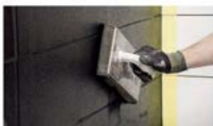
**14** Używać gąbki zwierzęcej i wyciągniętej, gdyż nadmiar wody może spowodować odbarwienie fugi. Profil fug można wykorzystać za pomocą grubego kabla elektrycznego.
