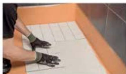
**6.** Uкладanie płyt podłogowych można rozpoczęć po około 2 godzinach. Kleje do płyt **Kilto Superfix DF, Lightfix i Kerapid DF** to niektóre kleje Kilto nadające się do przyklejania płyt na membranę.
