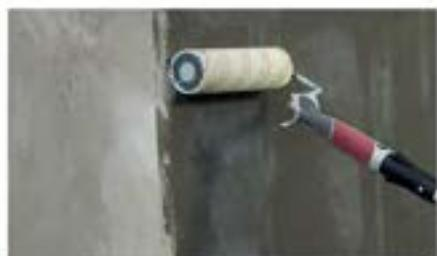
3 Zagruntuje suchą i odkurzoną ścianę Kilto Keraprimem wg instrukcji.
