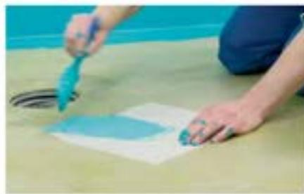
**1** Zagrunować suchą i odkurzoną podłogę za pomocą KILTO Keraprimer (rozcieńczyć wodą 1: 1).
