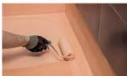
**5.** Nanieś **Kilto KeraPro** drugą warstwę na podłodze z zakładką na ścianę. Pozwól na wyschnięcie przez 2 godziny, aż do zmiany koloru. Użycie dla zakończonej hydroizolacji 0,75 l/m<sup>2</sup> przy grubości wyschniętej membrany 0,5 mm.
