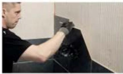
5. Można rozpocząć układanie płyt po około 2 godzinach. Kleje do płyt **Kilto Superfix DF**, **Lightfix** and **Kerapid DF** to niektóre kleje Kilto nadające się do przyklejania płyt na hydroizolacji.
