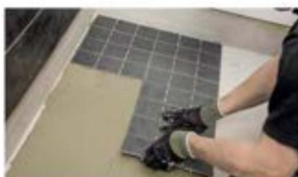
**11** Po wyschnięciu Keramiku rozpocząć układanie płyt na podłodze. Polecam klej **Kiltto Superfix DF**, **Kiltto Highflex S2** lub **Kerapid DF**.
