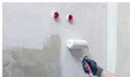
6 Narieść Keramix wałkiem na całą powierzchnię ścian i pozostawić do wyschnięcia minimum 1 godzinę, aż do zmiany koloru.
