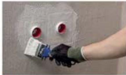
7 Następnie nałożyć drugą warstwę i pozwolić wyschnąć przez min. 1,5 godziny (zmiana koloru) przed układaniem płyt. Całkowite zużycie Keramixu musi wynieść min. 1,5 kg/m<sup>2</sup> i grubość min. 0,8 mm.
