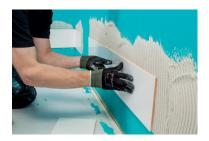
**6.** Fix wall tiles with Kiilto Superfix DF, Kiilto Saneerauslaasti or Kiilto Kerapid DF Pikasaneerauslaasti.
