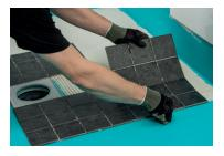
**12.** Fix the floor tiles with Kiilto Superfix DF, Kiilto Saneerauslaasti or Kiilto Kerapid DF Pikasaneerauslaasti.
